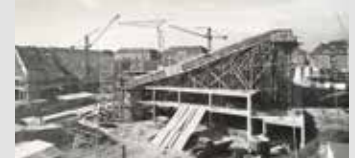
Bau der Wiener Stadthalle
